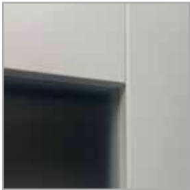
połączenie ramiaków pionowy z poziomym
