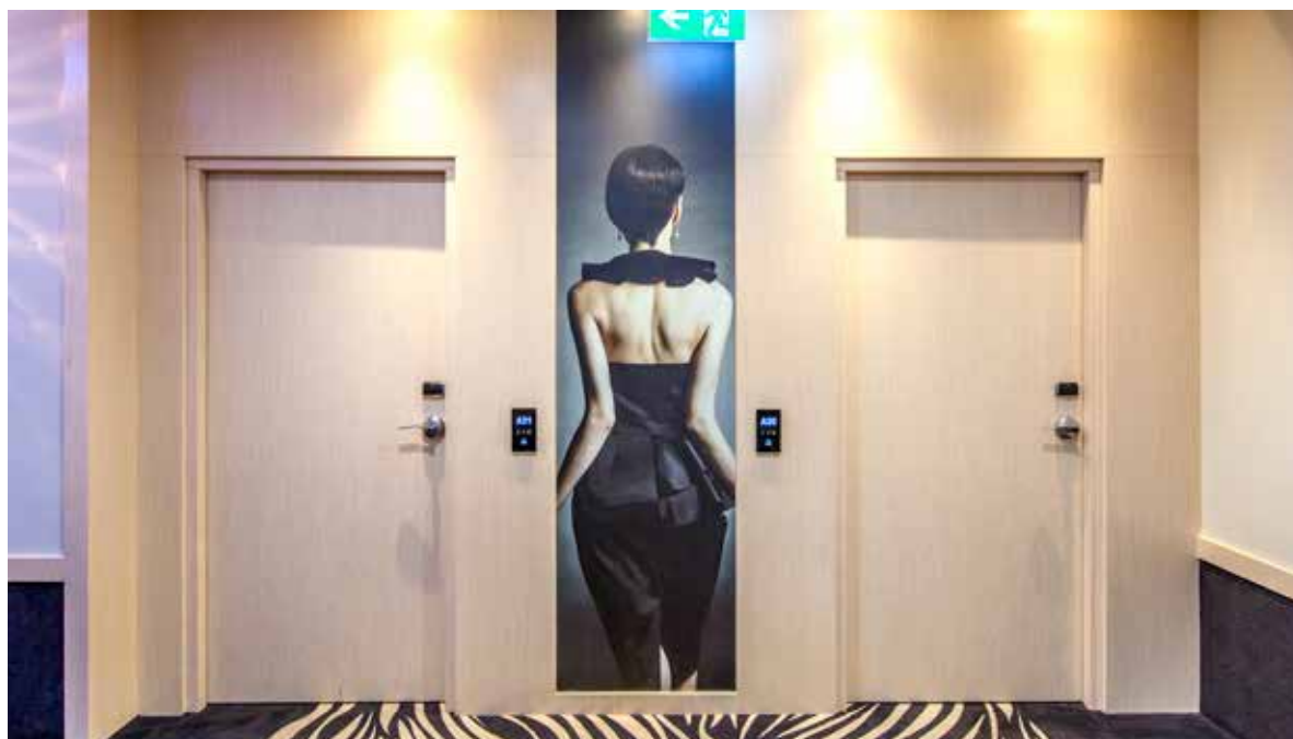
drzwi przeciwpożarowe FR EI30 SR 37dB, ościeżnica stała drewniana
